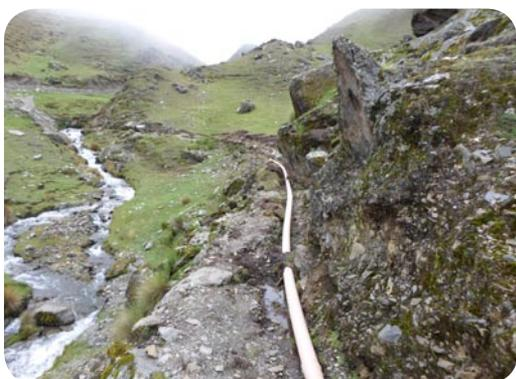
*Revestido con tubería PVC*
