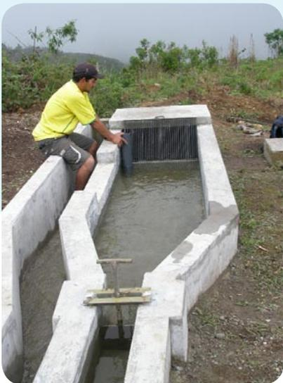
Se debe verificar que la tubería, rejilla y las compuertas de ingreso al desarenador y a la cámara no estén obstruidas.
