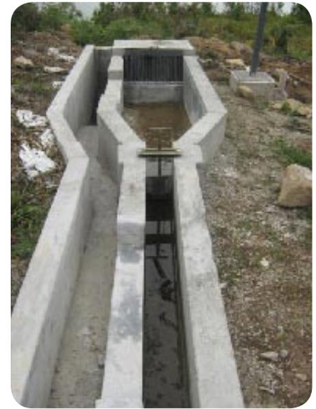
*Desarenador de hormigón armado*
