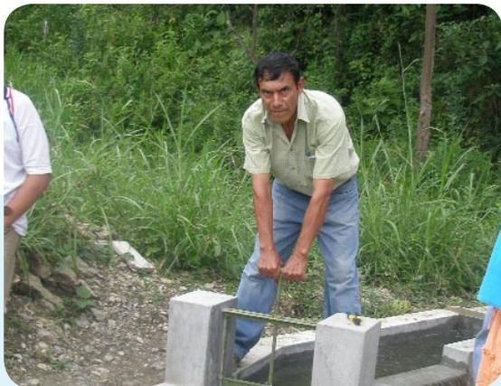
Cerrar la compuerta de ingreso al desarenador y a la cámara de carga.
