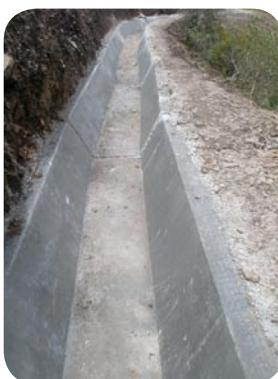
*Revestido con hormigón*
