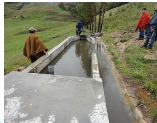
La tubería de presión debe estar llena y sin fugas, al igual que la cámara (con rebalse).
