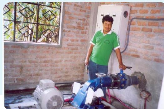
El agua debe ingresar desde la cámara de carga hacia la tubería lentamente, esto se logrará regulando la válvula de ingreso al desarenador y a la cámara.
